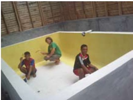
die Fischzuchtbecken bekommen den letzten Anstrich
