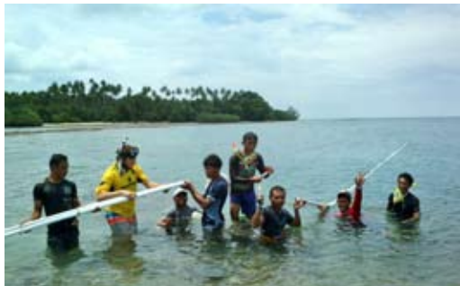
gemeinsames Verlegen der 260m langen Meerwasserleitung für die Fischzucht
