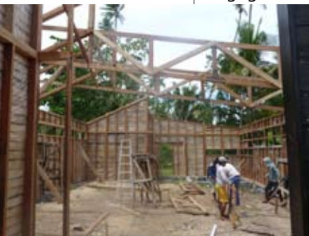
ein Gebäude wird errichtet
