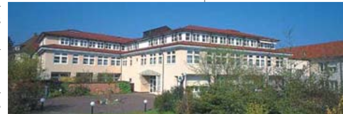
Das Gebäude des Oberkirchenrats auf der Stuttgarter Gänsheide
